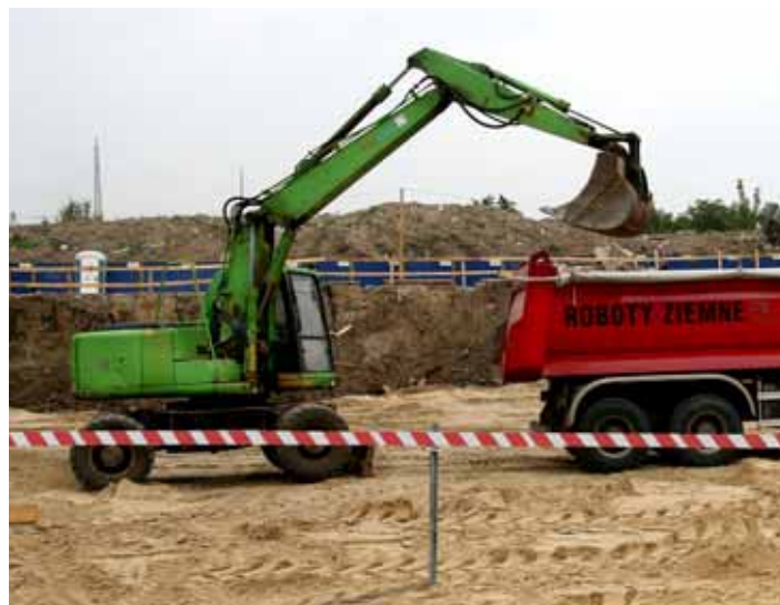
Wydzielenie strefy pracy maszyny. Oznakowano ją taśmą w barwach bezpieczeństwa.
