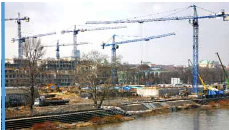
Budowa Centrum Naukowego im. Kopernika w Warszawie.
