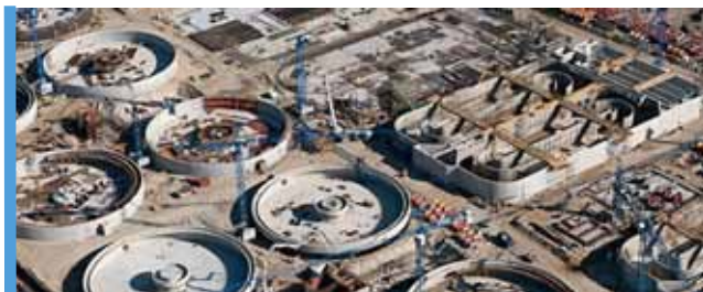
Teren budowy oczyszczalni ścieków.
